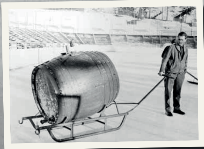
En gammal öltunna användes vid istillverkning. Vid kranen på baksidan satt ett långt rör med säckar som fördelade vattnet på isen. Två man drog ekipaget och en person gick bakom för att reglera vattenflödet. På bilden: Ulf Lundström
